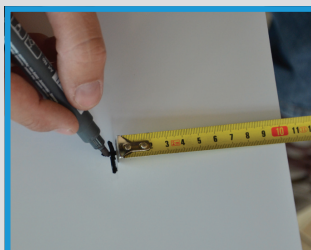
3) Naměřte a vyznačte bod ve vzdálenosti 10x10cm od každého rohu obkladové desky
