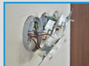
11) Nasadte prodlužovací kroužky na elektroinstalaci krabice a připevněte je prodlouženými šrouby
