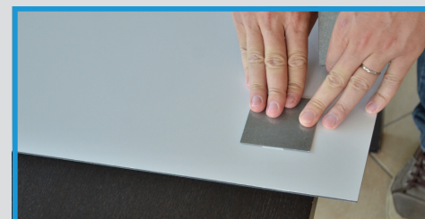
9) Nalepte plechové čtverce na vyznačené body na obkladovém panelu. Střed čtverce s přesností +/- 2cm na značku.
