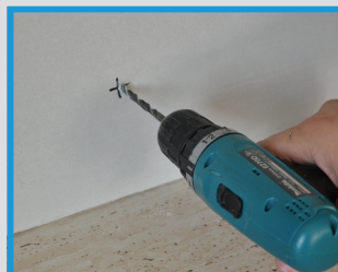
7) Vyrvejte díry, a umístěte hmoždinky. Stačí přesnost +/- 2cm od vyznačených bodů
