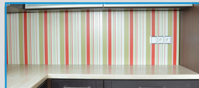
15) Připevněte plastové kryty elektroinstalace
