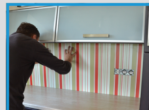
13) Prostrčte jednotlivé prvky elektroinstalace výřezem v panelu a panel přitlačte ke zdi. Ujistěte se, že všechny magnetické spoje dobře drží.
