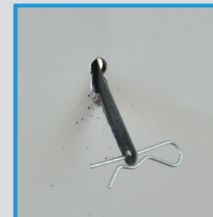
TIP! Abyste předešli nechtěnému poškození pohledové strany obkladu (pokud by pilka vyklouzla z řezu a poškrábala povrch), zajistěte prostrčený plátek pilky závlačku.
